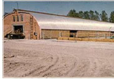
8. kép: Íves faszerkezetű istálló
