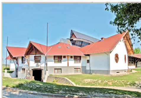
13. kép: Az új lovarda a lovasbejáró felől
