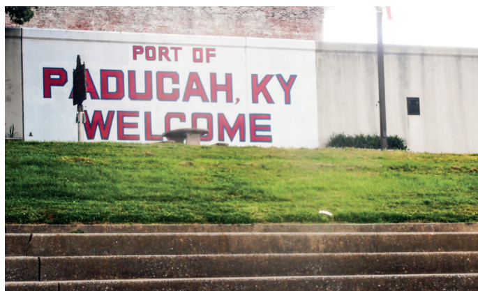
ÁRVÍZVÉDELMI FAL A MISSISSIPPI FOLYÓNÁL
